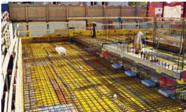
Deckenlagerung mit Erschütterungslager
