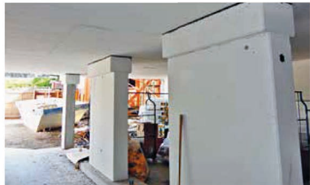
Auflagerausbildung mit Erschütterungslager
